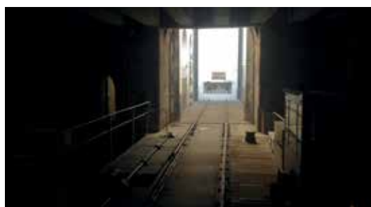
[5] CARRELLO TRASLATORE E ASCENSORE MONTAVAGONI
